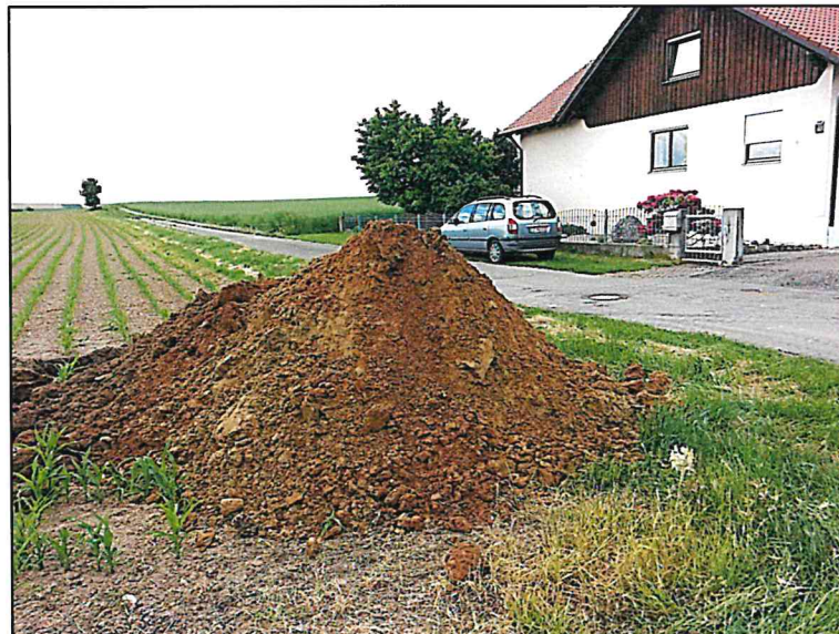
Lage Schurf 2/ Sickergrube, Blick nach Südwest
