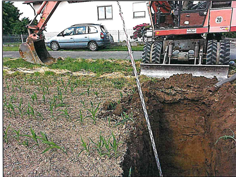
Lage Schurf 2/ Sickergrube, Blick nach West
