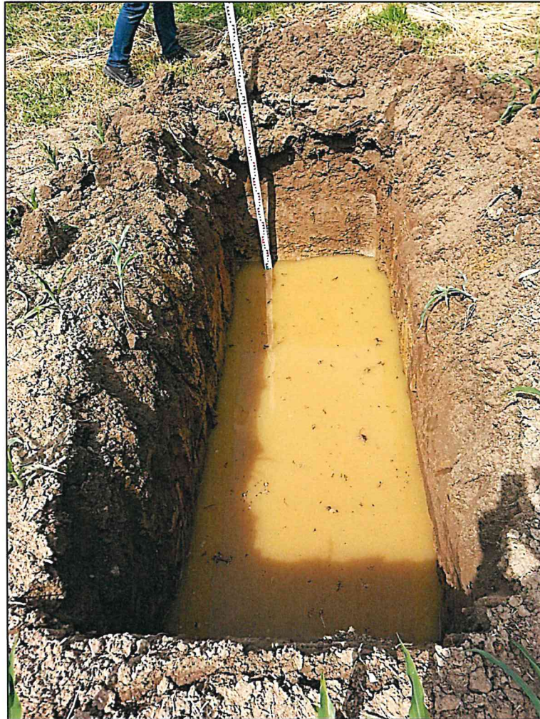
Wasserstand in der Sickergrube/ Schurf 2 nach 15 Minuten des Sickerversuchs
