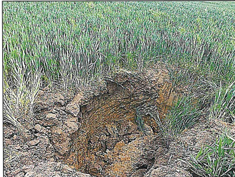
Schurf 3, Zusammenfallen ca. 30 Minuten nach Aushub
