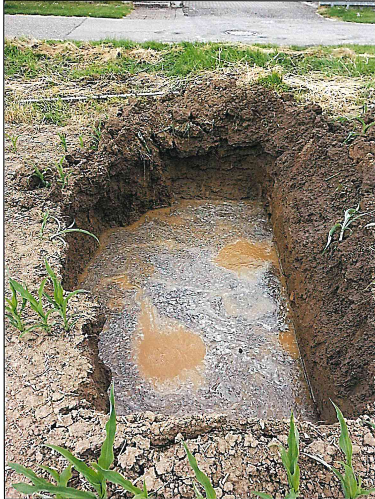
Wasserstand in der Sickergrube/ Schurf 2 zum Ende des Sickerversuchs nach 60 Minuten
