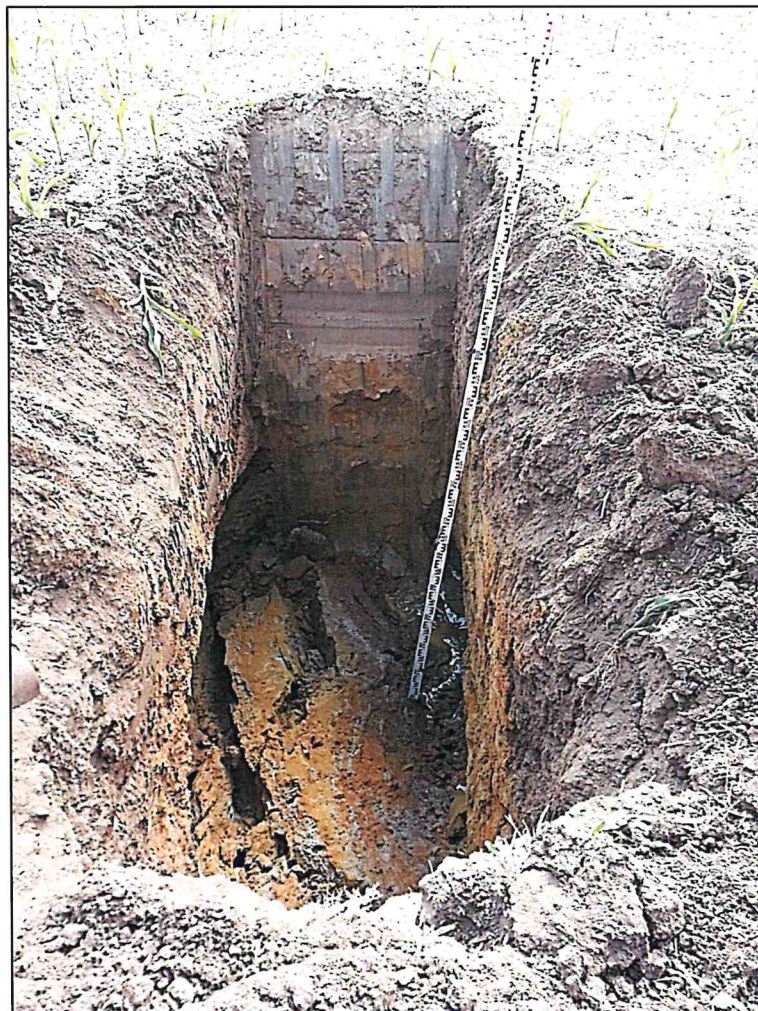
Blick in den Schurf 2/ Sickergrube, Endtiefe 2,5 m u. GOK
